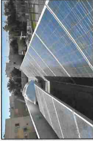
الالواح الشمسية: 20 لوح شمسي بكفاءة 250W لكل لوح
